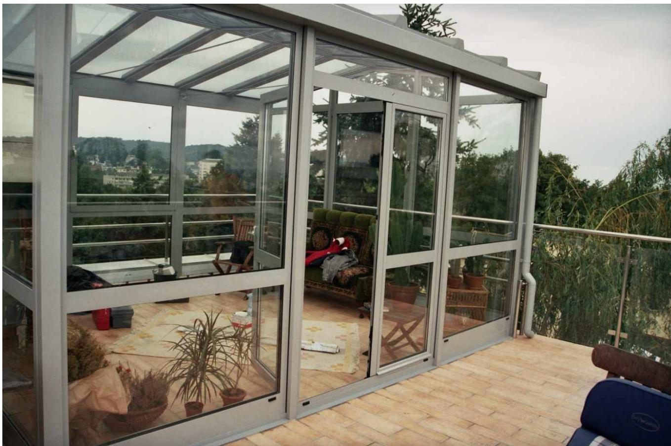
Вертикальное остекление в зимних садах представляет собой конструкции из алюминиевого и ПВХ профиля. Они устанавливаются в проем, образуемый фундаментом, стойкой, желобом или боковой стропилой.
