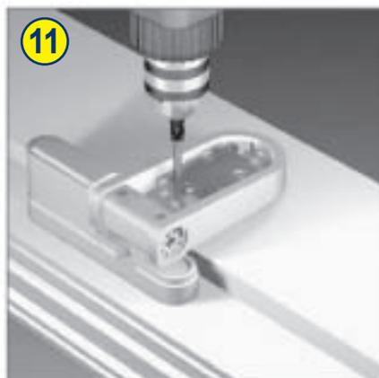
11 Возможно дополнительное крепление регулировочной каретки двумя шурупами (не входят в комплект поставки).
